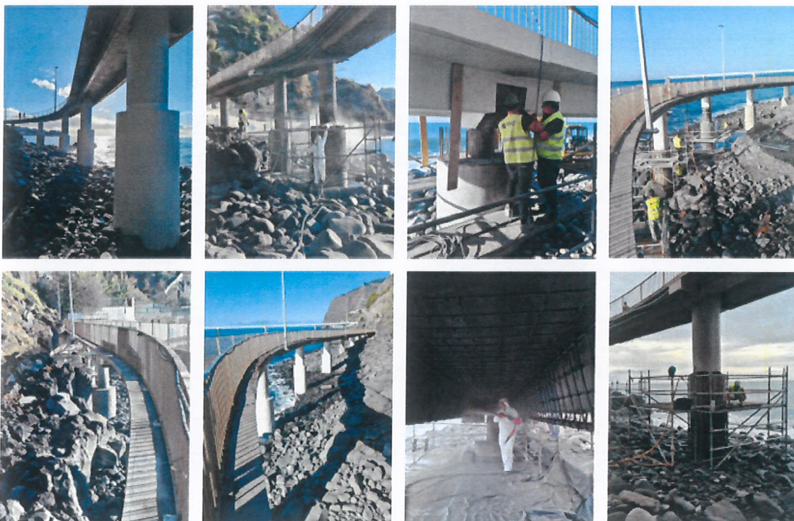
Fotos dos Trabalhos da Empreitada da 1ª Fase
